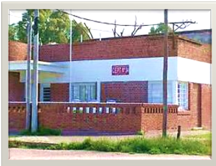
Foto N° 2: Foto edificio del CEPT N° 34 en Ochandio.
